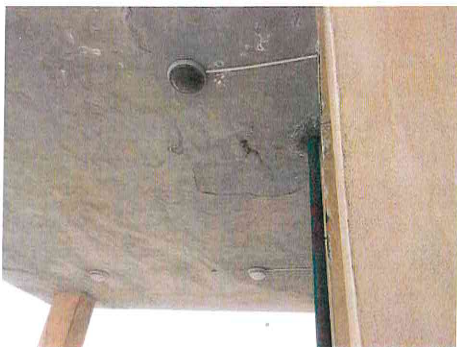
Particolare pensilina fronte mare.
