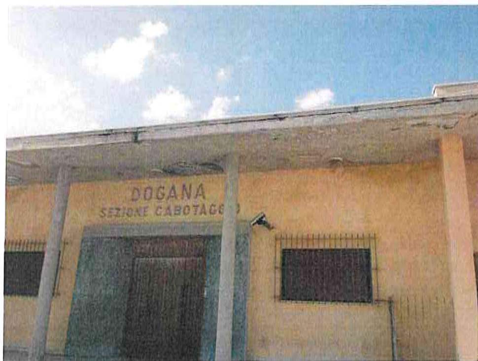
Particolare cornicione pensilina
