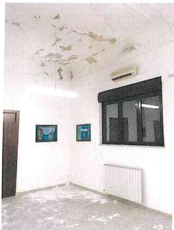
Particolare soffitto androne.
