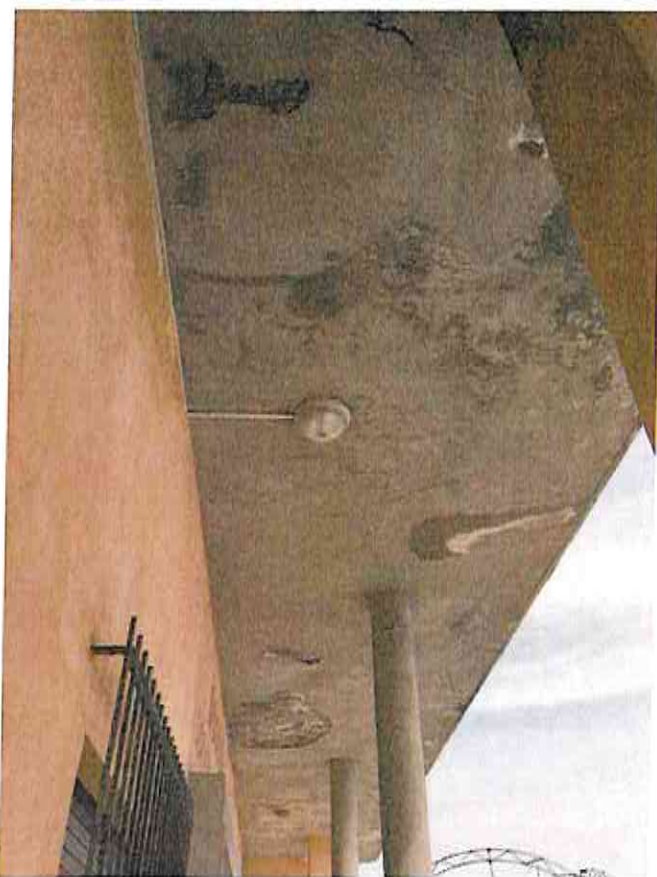
Particolare tettoia fronte mare.
