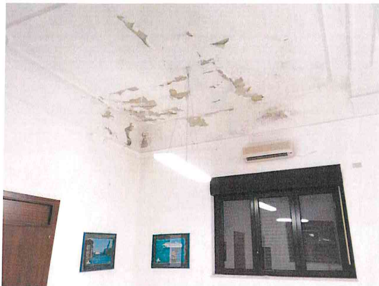
Particolare soffitto ufficio.
