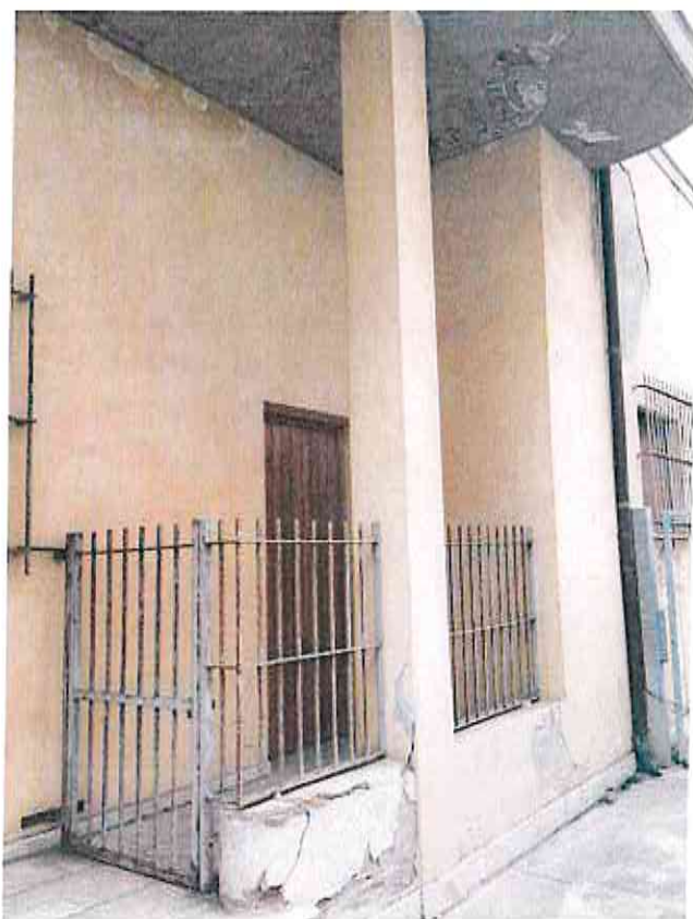
Particolare prospetto est
